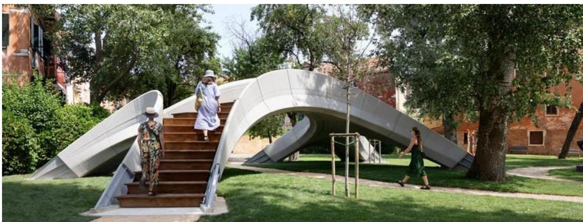
Figura 2-12. ETH Zurich: puente impreso en 3D sin refuerzo estructural. Fuente: [62].
