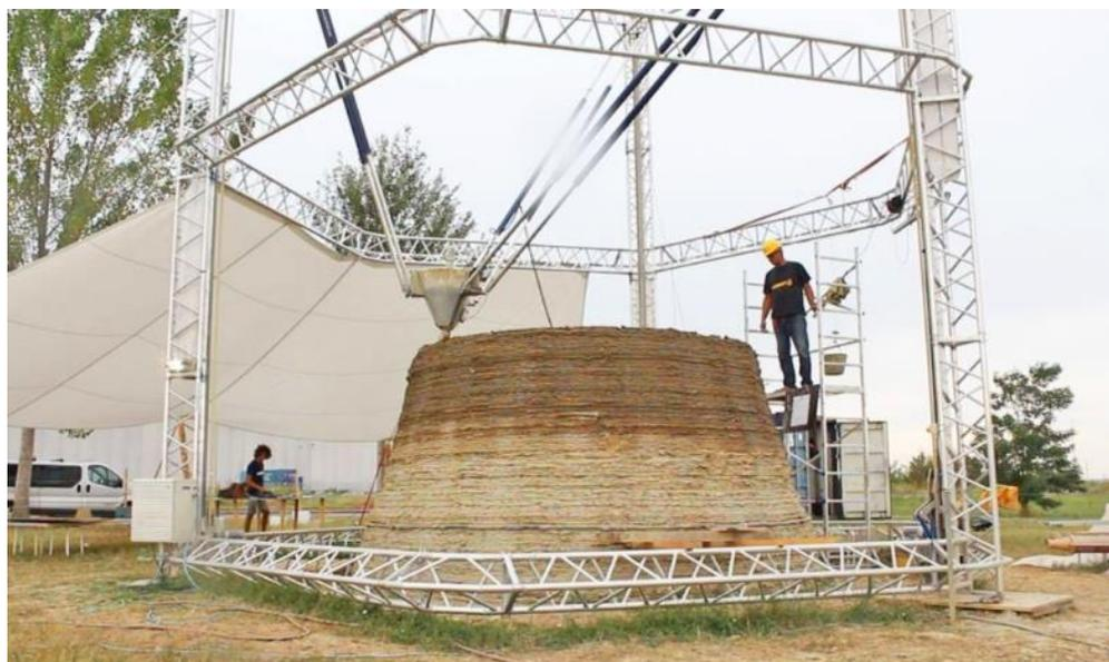
Figura 2-18. Impresora delta en obra insitu. Fuente: [Wasp](#).
