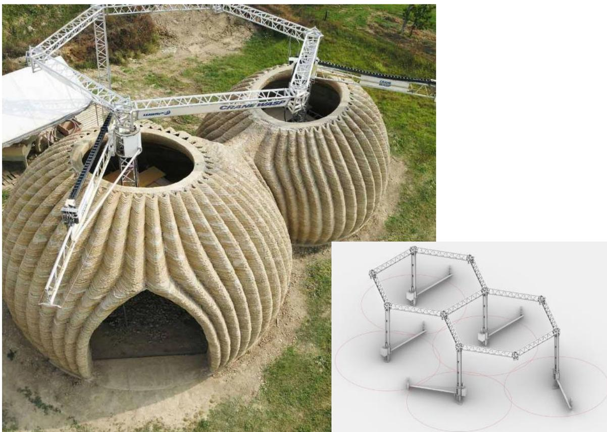
Figura 2-21. Sistema de impresión polar fijo porticado. Fuente: [Wasp](#).
