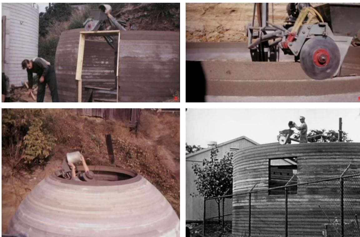
Figura 2-1. Trabajos realizados con la máquina de construir muros, 1930. Fuente: [38].
