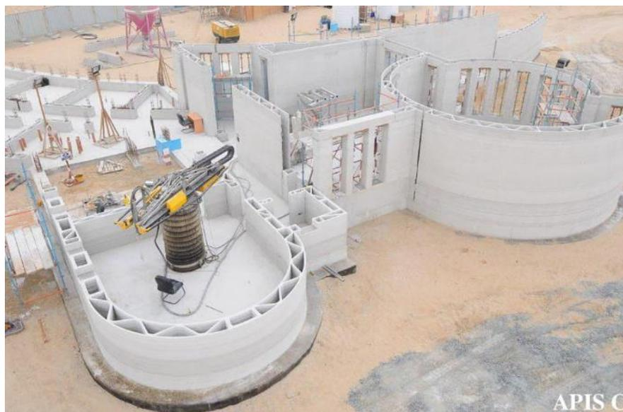
Figura 2-8. Apis Cor: impresión en 3D de edificio de 2 plantas y 640 m<sup>2</sup>. Fuente: [48].
