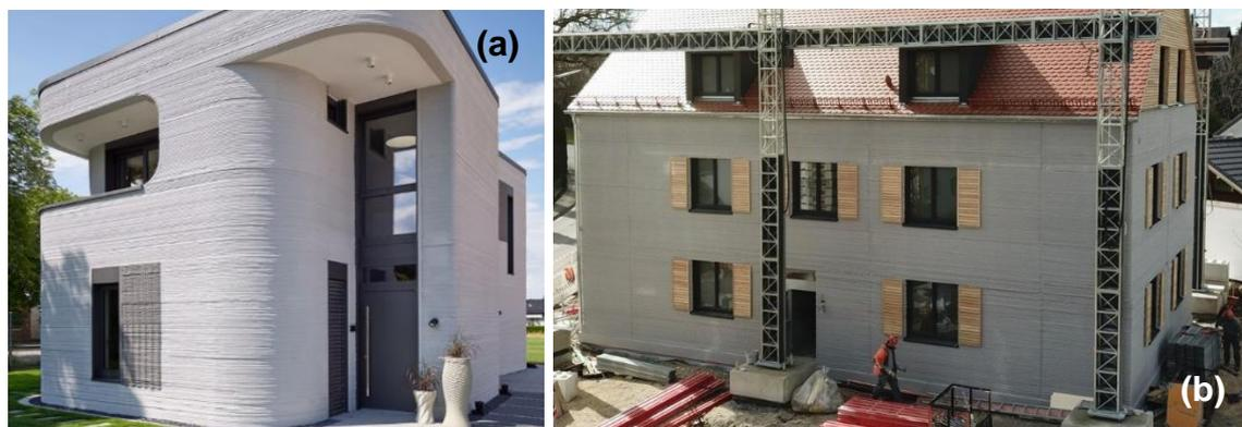
Figura 2-9. PERI: (a) Edificio residencial de 160 m<sup>2</sup> impreso en 3D. (b) Impresión de edificio de apartamentos de 840 m<sup>2</sup> cubiertos. Fuentes: [57,58].
