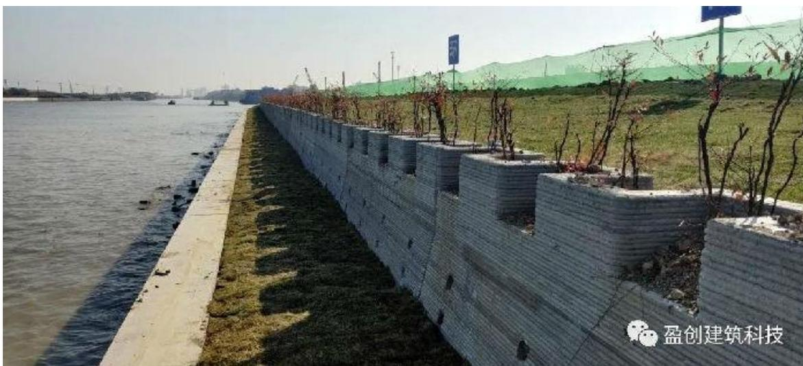
Figura 2-7. Winsun: muro de protección costera impreso en 3D. Fuente: [55].
