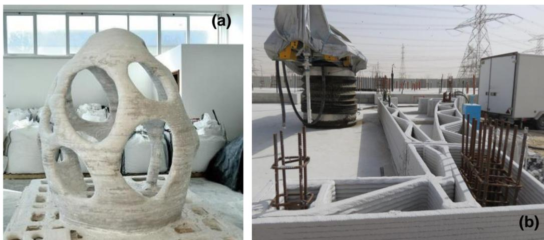
Figura 2-3. (a) Impresión 3D mediante *D-Shape*. (b) Impresión 3D mediante *Contour Crafting*. Fuente: [47,48].
